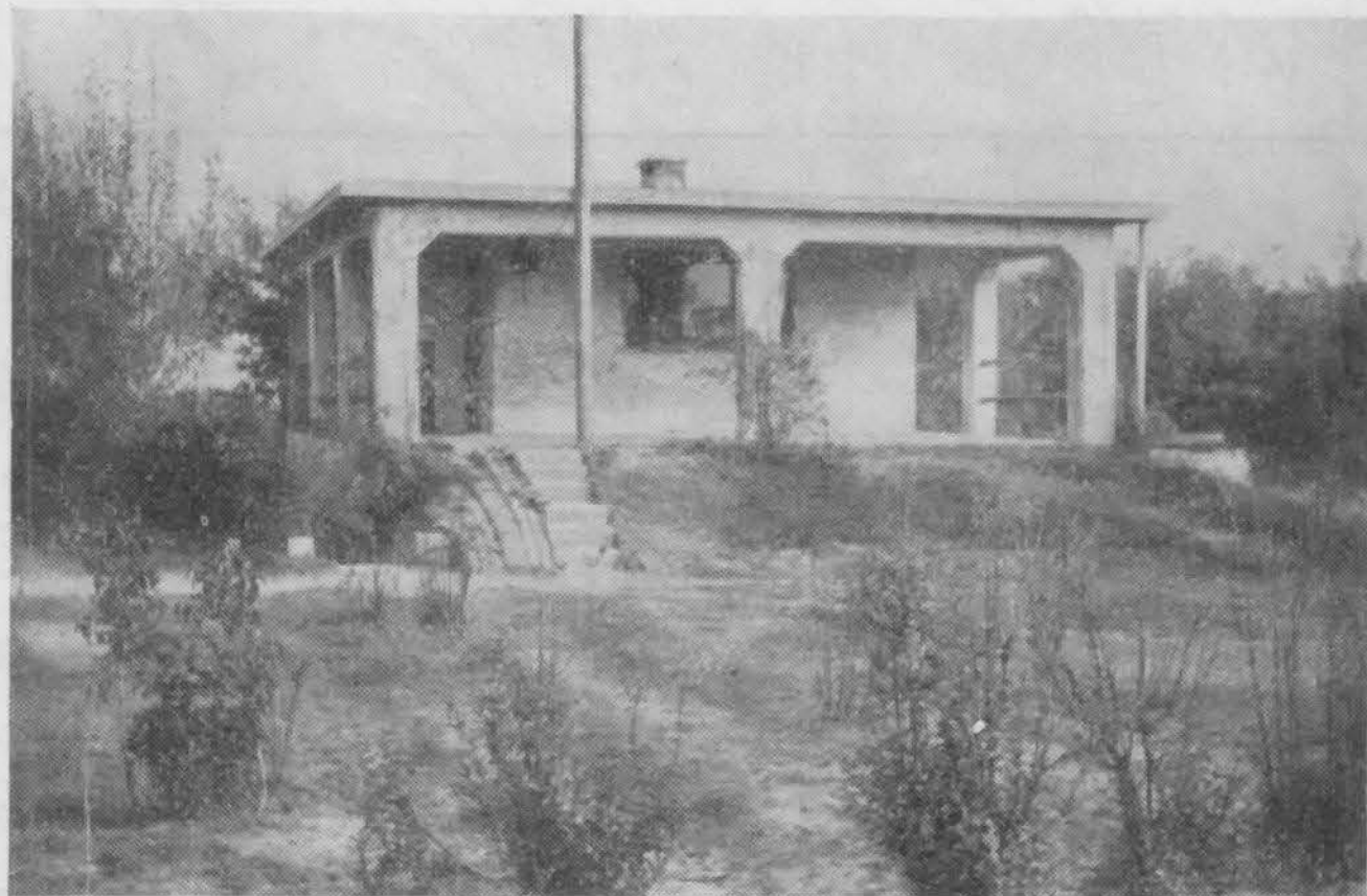
Bunker „De Aenstoot”. Boven: het dagverblijf; beneden: slaapruimten (de ramen van de kamers aan de Noordzijde zijn nog juist te zien). (In vak 5)
