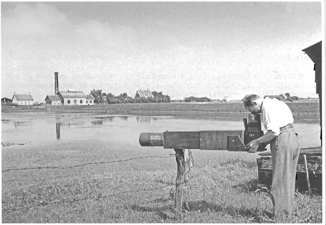
F.P.J. Kooijmans met zijn zelfgebouwd telekanon bij de spuiboezem van Flauwers. Het gemaal is er nog steeds, maar de schoorsteen is verdwenen. Foto: Rykel te Kate, 29 augustus 1937.
